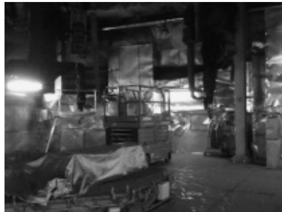
2号熱交換器撤去完了
